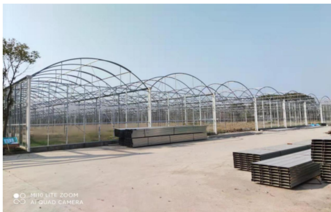
连栋温室顶膜未安装
